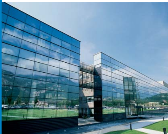
Soitec, site de production Bernin I et II © Soitec/Christian Morel
