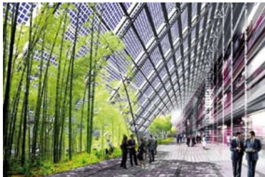
La galerie du ruban photovoltaïque du projet Giant
